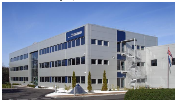
Gambar 5.3. Gedung adalah contoh modal tetap (sumber: reidsteel.com)
